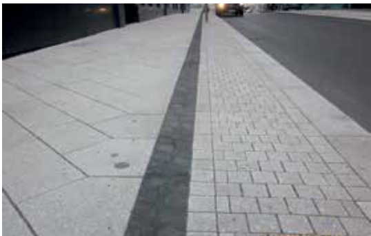
Figur 6.4 Råsplittet mørk basalt plater som ledelinje mellom gradhugget belegget av plater og gatestein (foto: René Kierstein)
