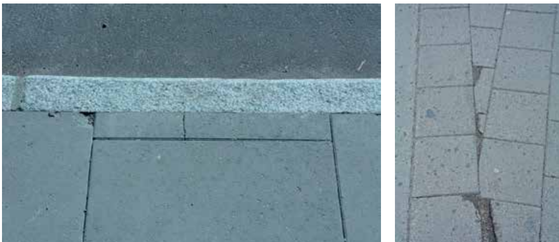
Figur 4.5 Eksempler på dårlig tilpasning, for lite bredde og manglende fuger inntil kant og nabostein (foto: René Kierstein)
