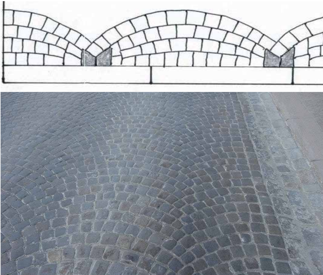
Figur 5.10 Eksempler på buesetting (illustrasjon og foto: René Kierstein)
