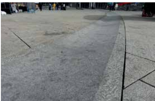
Figur 6.6 Granittplater utformet som vannrenne på Stavanger torg (foto: René Kierstein)
