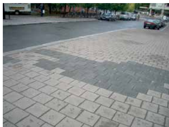
Utbedring av gammelt dekke med nye heller
