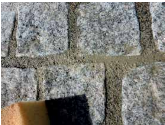
Figur 7.7 Refuging med reparasjonsmørtel (foto: Rudi Grimelid)
