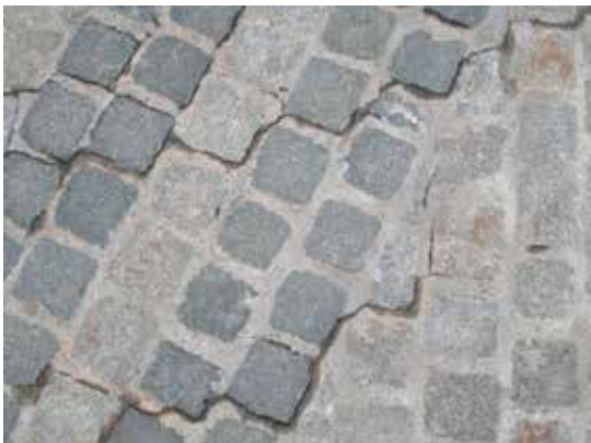
Figur V1.5 Spenningskader (foto: René Kierstein)
