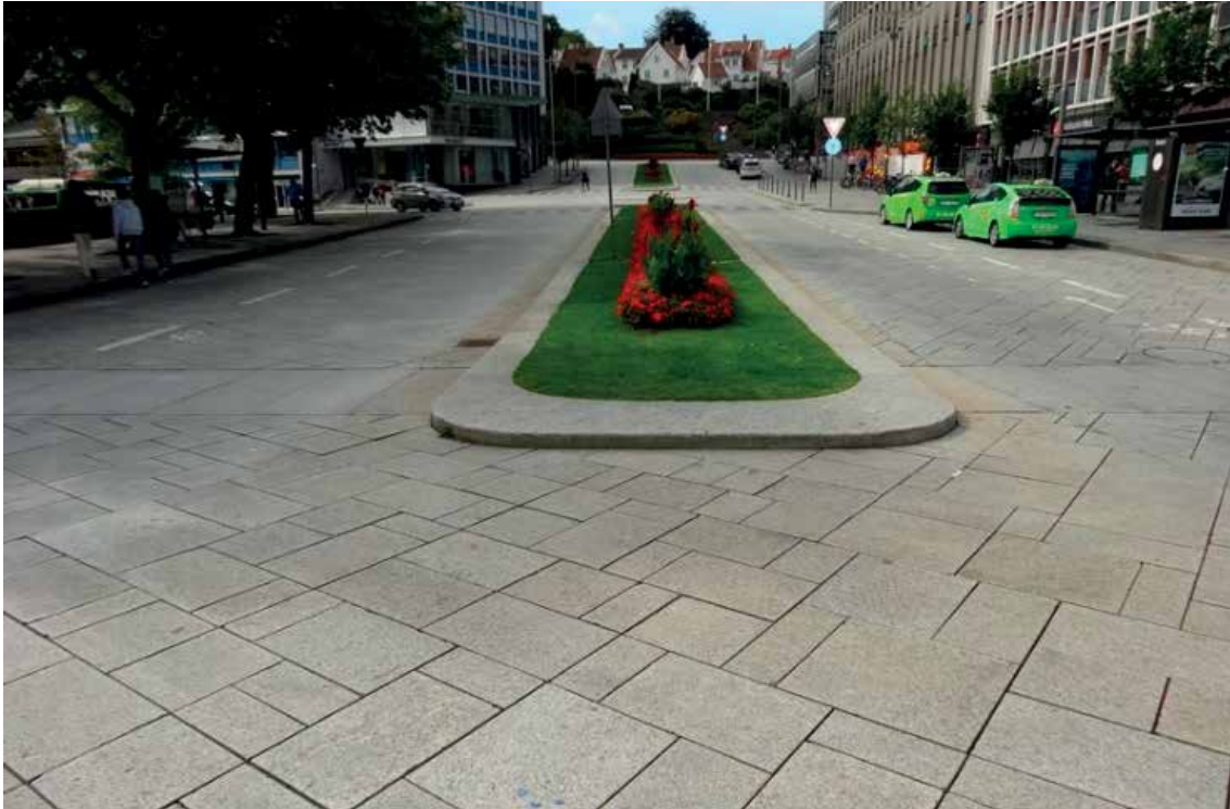
Figur 6.1 Granittplater i kjørebane i Stavanger sentrum (foto: René Kierstein)
