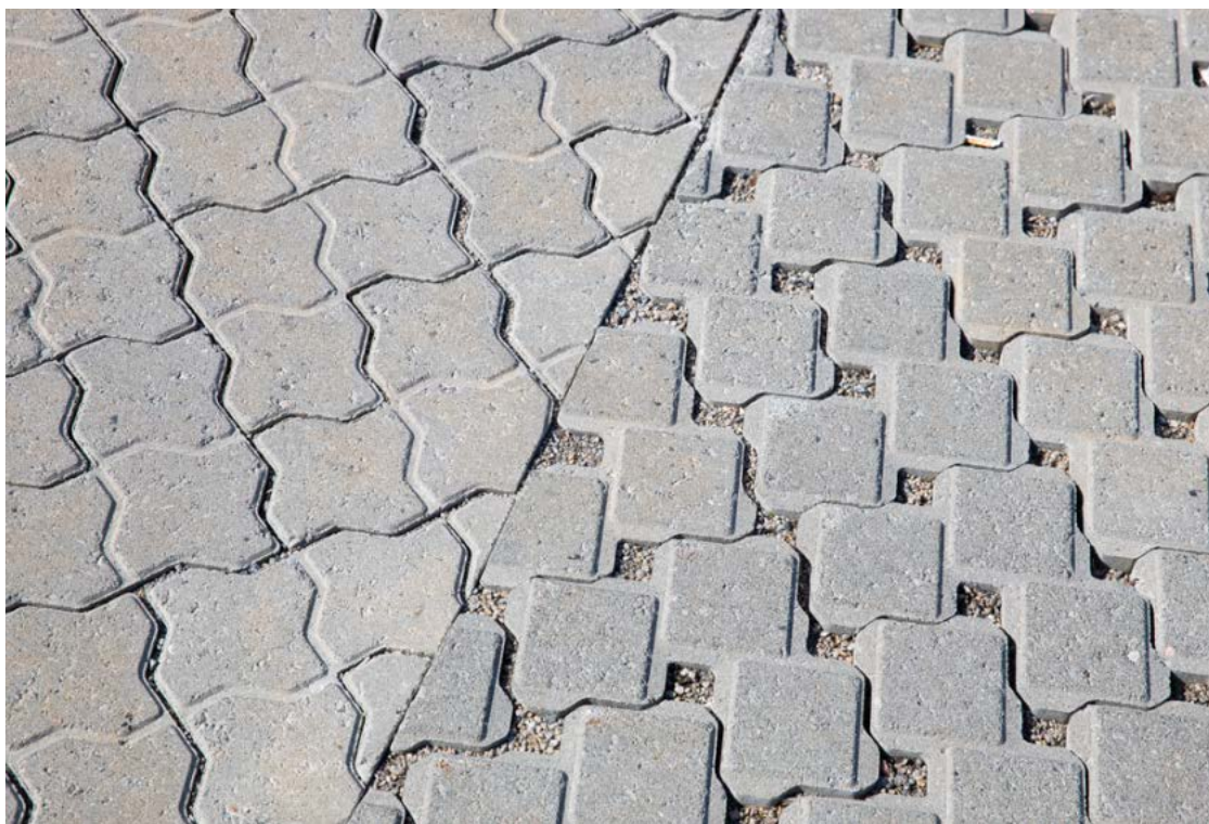
Figur 1 Prinsipiell forskjell mellom vanlig belegningsstein (venstre) og stein beregnet for permeabelt dekke (høyre) (Foto: ASAK Miljøstein).
